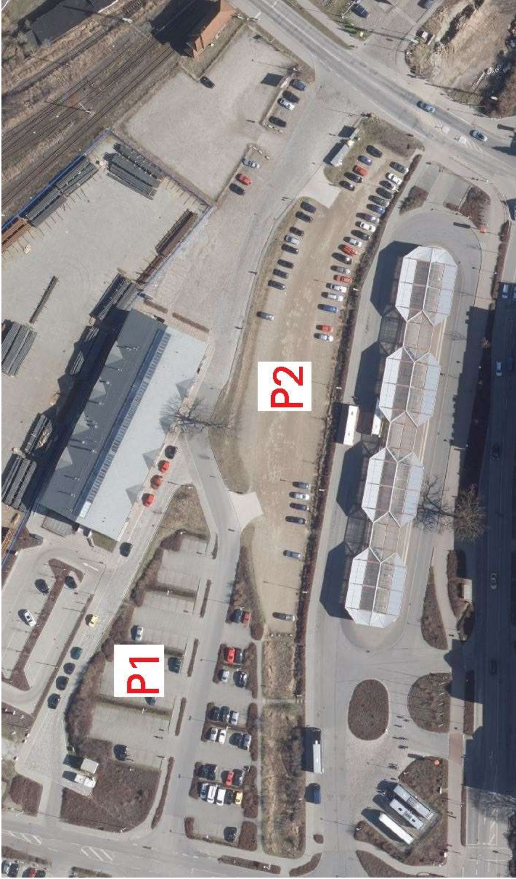
Anlage PP Altstadt/Bahnhof/ZOB
